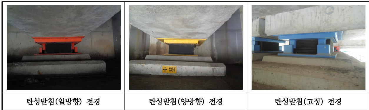
【사진 1.3.10】 교량받침 전경
