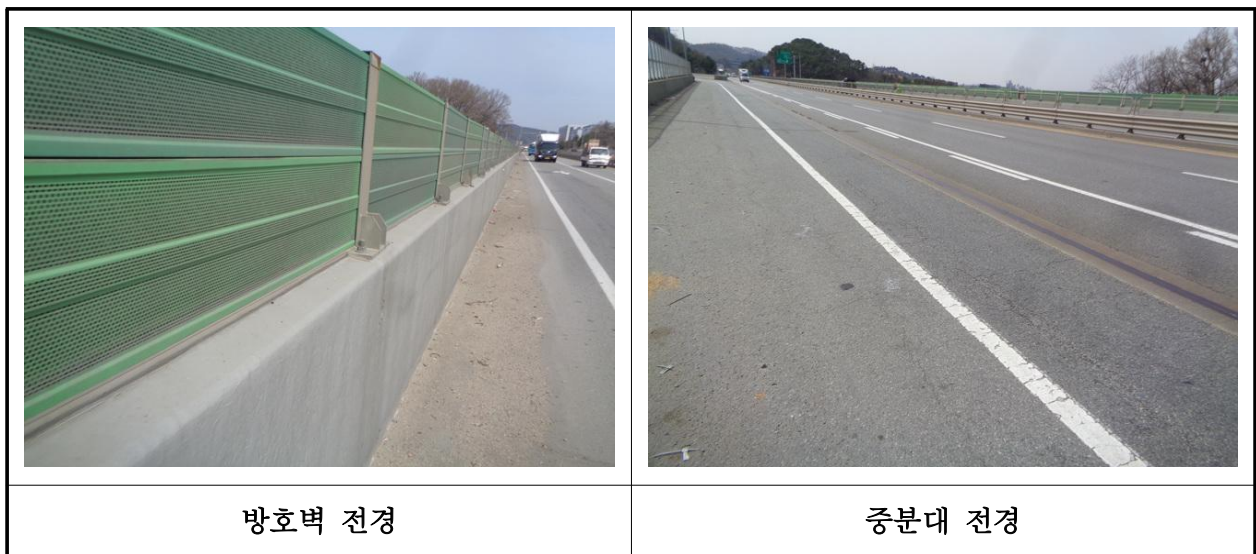
【사진 1.3.19】 난간 및 연석 전경
