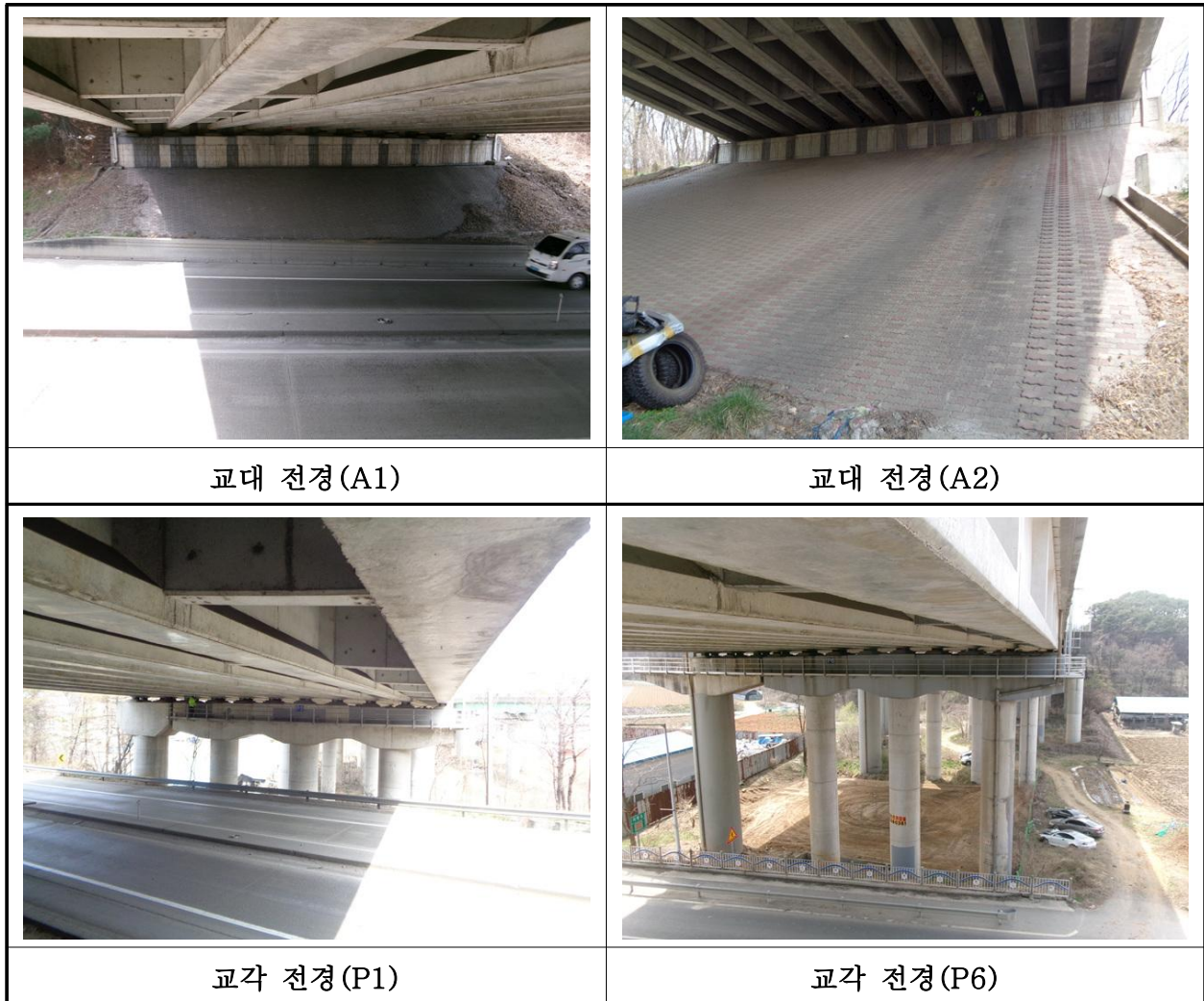
【사진 1.3.8】 교대 및 교각 전경
