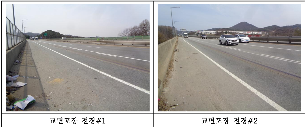
【사진 1.3.15】 교면포장 전경
