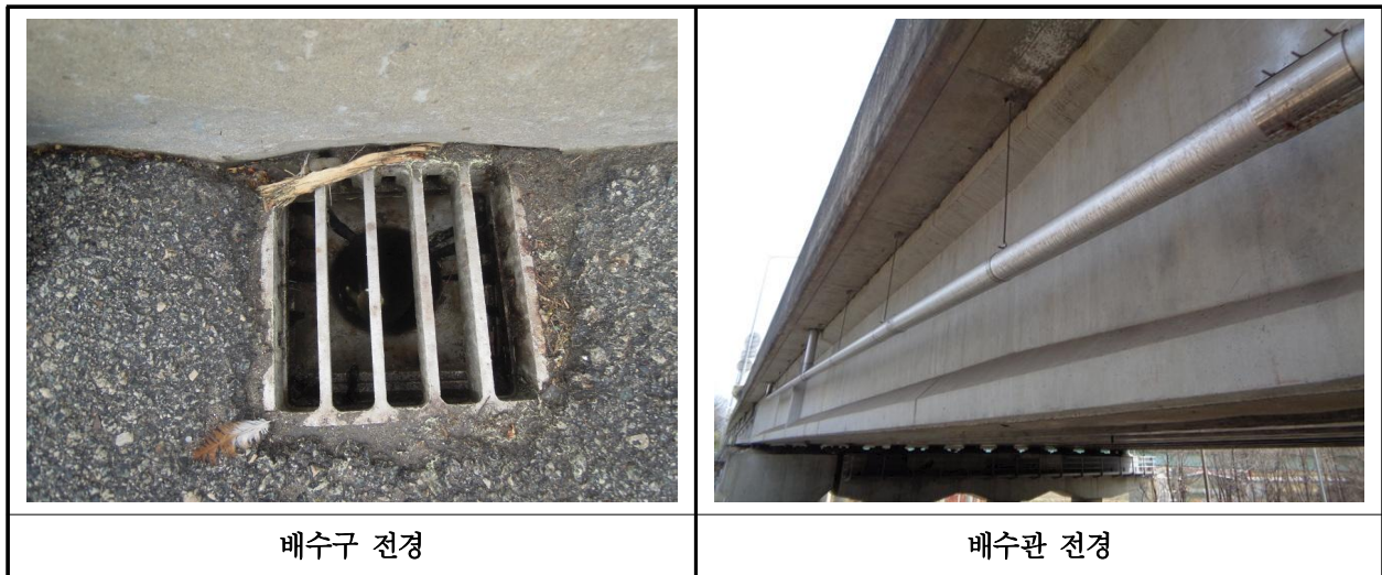
【사진 1.3.17】 배수시설 전경
