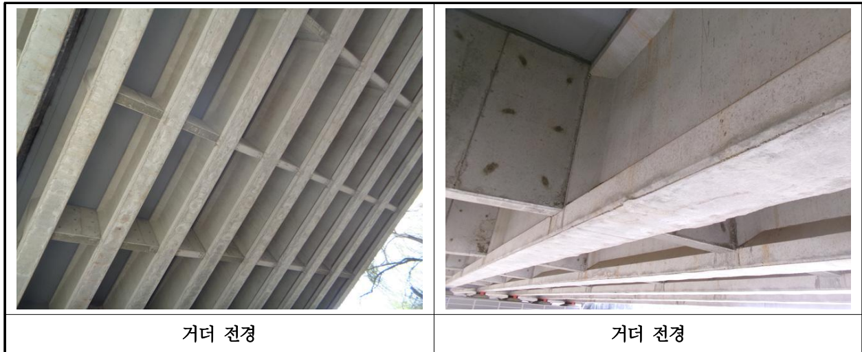
【사진 1.3.4】 거더 전경
