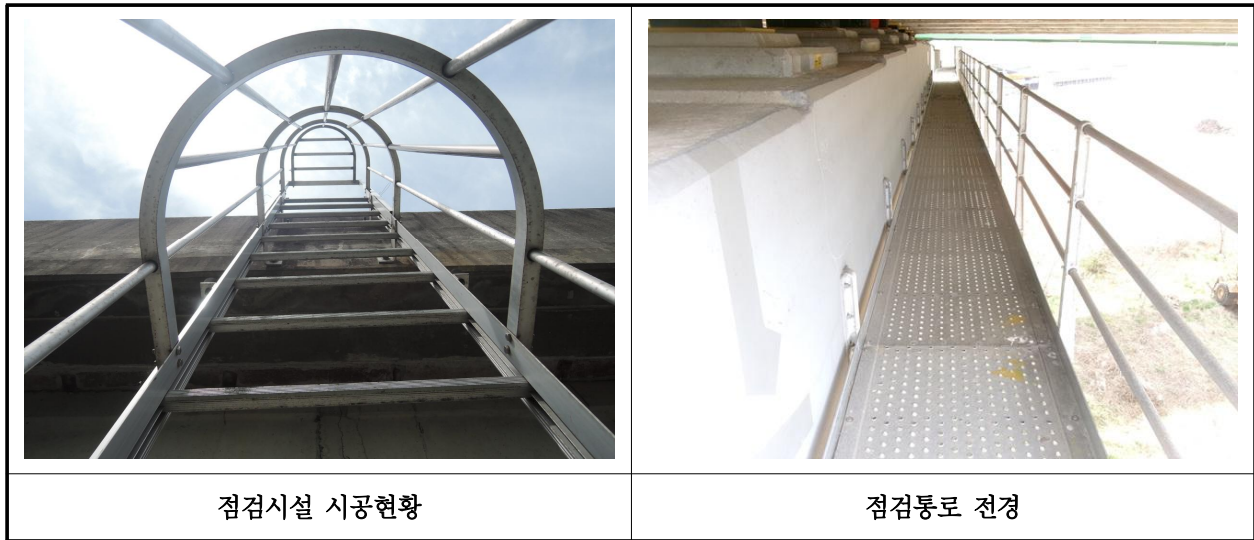
【사진 1.3.21】 교량 점검시설 전경
