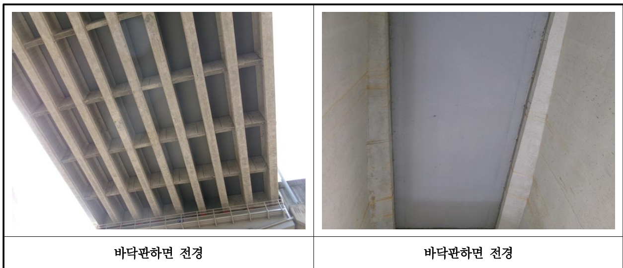
【사진 1.3.2】 바닥판하면 전경
